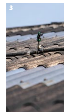
1 De vijver dient als waterverzamelplaats en infiltratieput. 2 Door een keienbak rondom de stal te plaatsen, zijn er geen dakgoten nodig. 3 Het regenwater wordt gebruikt om het dak te koelen, en zo het dierenwelzijn te verhogen.
